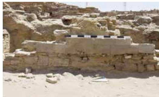
د. المبنى F-b1 من الشرق ويظهر إعادة بناء جدار الفناء (شمالاً). b. Building F-b1 East, rebuilt courtyard wall (North).
